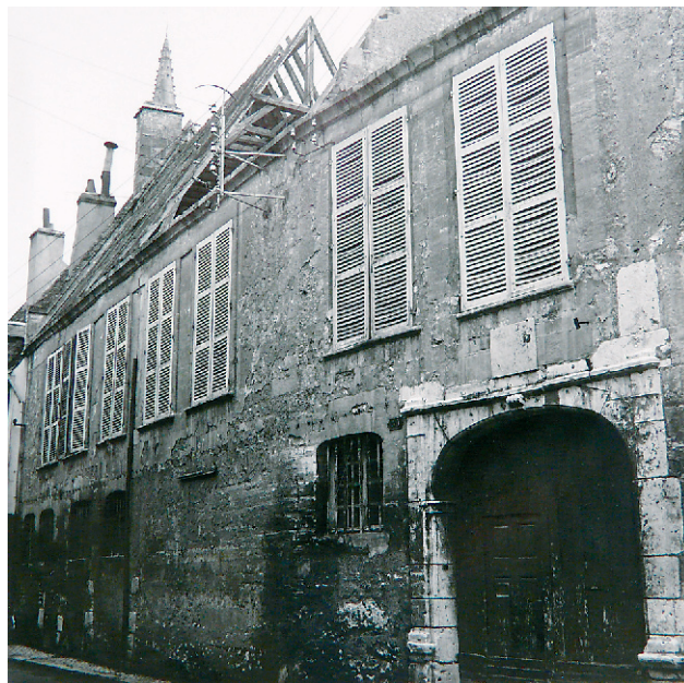
Fig. 28 : Poursuite de la démolition par le démontage de la charpente (coll. ISV).
