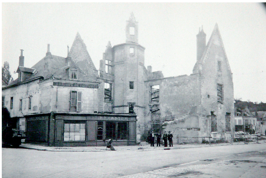
Fig. 20 : Le Logis, photographie prise du côté de la rue après l'incendie (coll. ISV).
