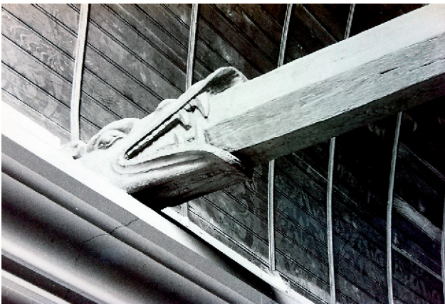
Fig. 35 (à gauche) : Détail d'un entrail sculpté à engoulant en gueule de dragon (Médiathèque du Patrimoine). Fig. 36 (à droite) : Détail d'un entrail sculpté à la jonction avec le poinçon vertical. Il est ici décoré de pampres de vigne et de grappes de raisin (Médiathèque du Patrimoine).
