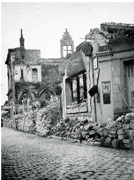
Fig. 5 : Les arcades orientales de la halle, invisibles jusqu'alors, sortent des ruines des maisons mitoyennes (coll. ISV).
