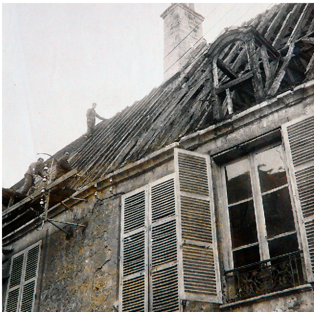
Fig. 27 : Démontage de la couverture du toit de l'Hôtel de Gennes, en avril 1960 (coll. ISV).
