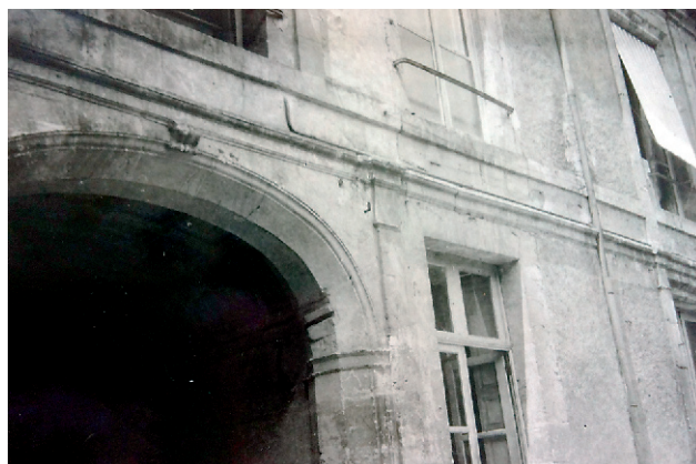
Fig. 24 : Vue de la façade arrière de l'Hôtel de Gennes donnant sur la cour (Médiathèque du Patrimoine).
