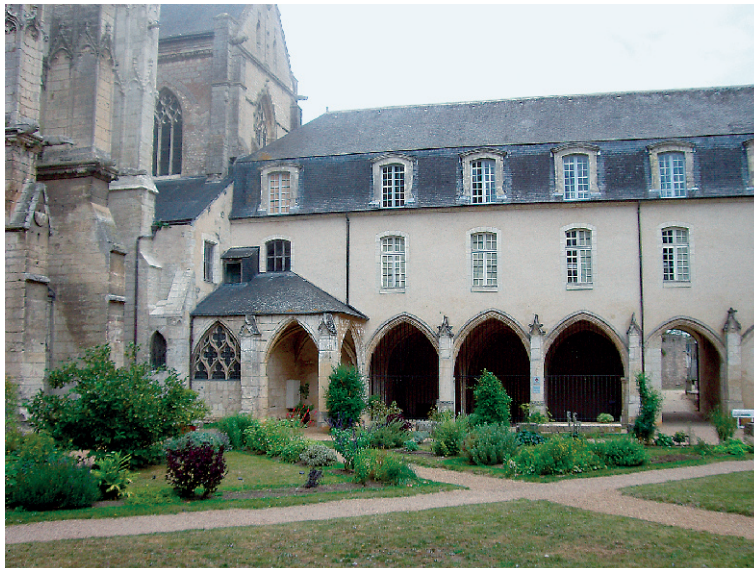
Fig. 12 : La cour du cloître, aile 'est' et la salle capitulaire, de nos jours (coll. part.).
