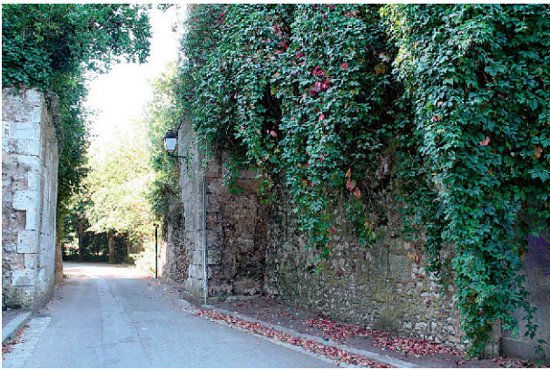
Fig. 6 et 7 : Porte du jardin de G. Launay, en haut de la rampe du château [Cl. M. Loisel].
