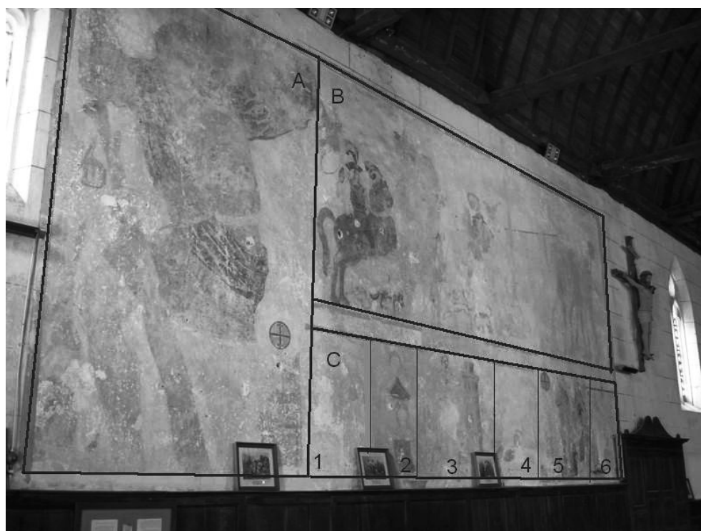
Illustration n° 2. — Villiers-sur-Loir : vue générale du mur nord
