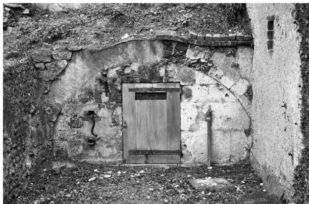
Mur fermant l'accès à la fontaine et manivelle de la pompe
