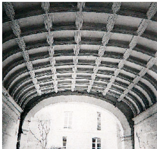
Fig. 26 : Le plafond à caissons sous le porche (coll. ISV).
