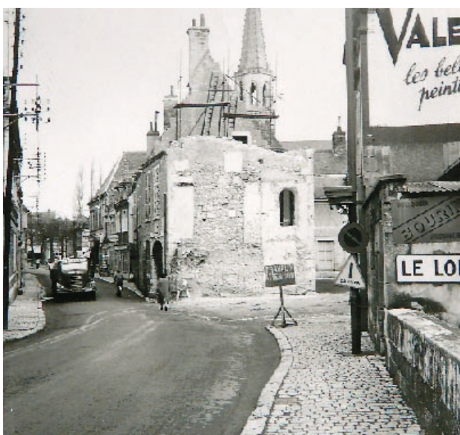
Fig. 29 : Les travaux de démolition de l'Hôtel de Gennes en cours d'achèvement, photographie prise depuis la rue (Médiathèque du Patrimoine).
