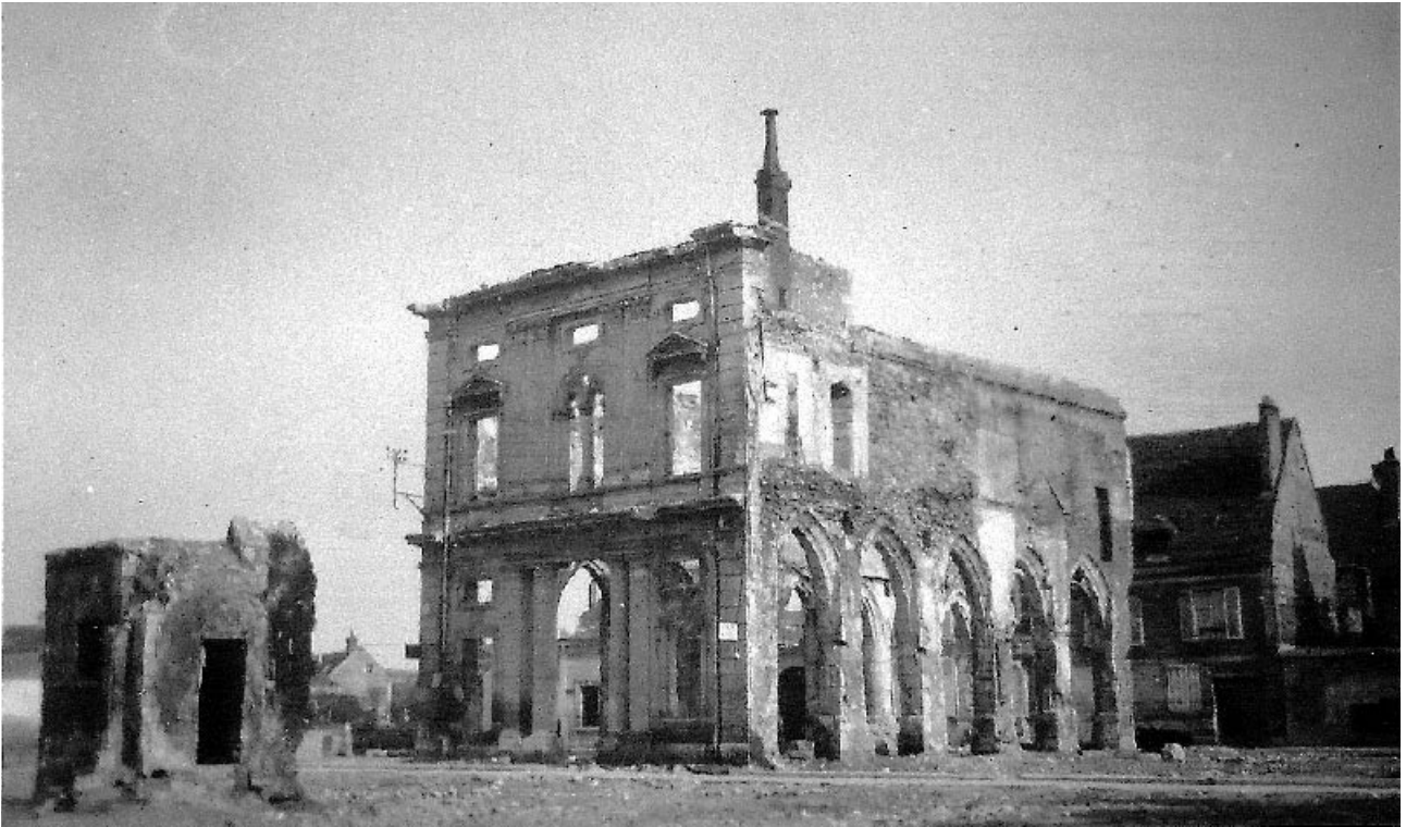
Fig. 7 : De l'ancienne Grande Rue, seuls subsistent désormais, face à face, le petit oratoire et la halle. À l'est, trois des huit arcades ont été abattues ainsi que les lucarnes, déposées dans le jardin du musée, et disparues depuis (coll. ISV).
