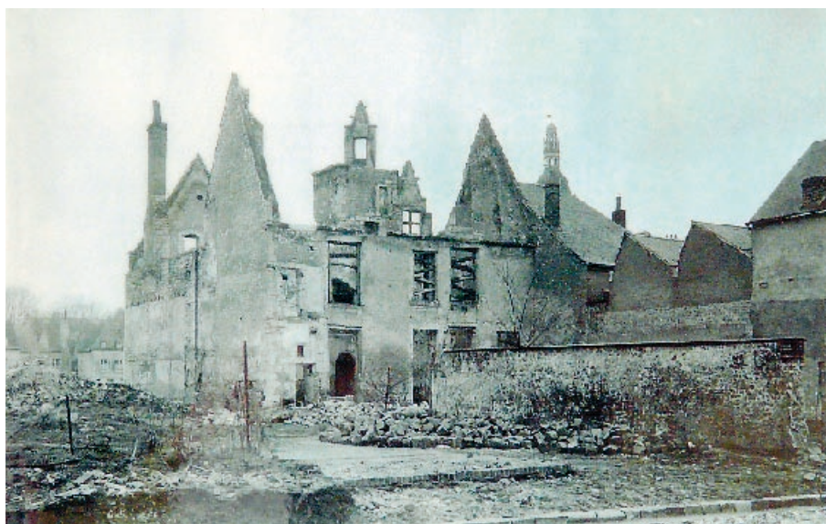
Fig. 21 : Vue prise à l'arrière du Logis, montrant la partie servant d'habitation (coll. ISV).
