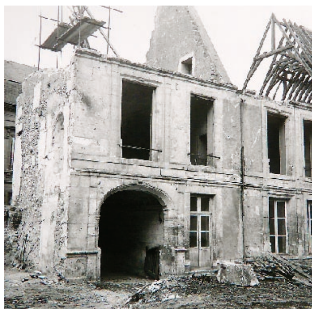
Fig. 30 : Même campagne de photographies. Les travaux de démolition opérés en 1961-1962, photographie prise depuis la cour (coll. ISV).
