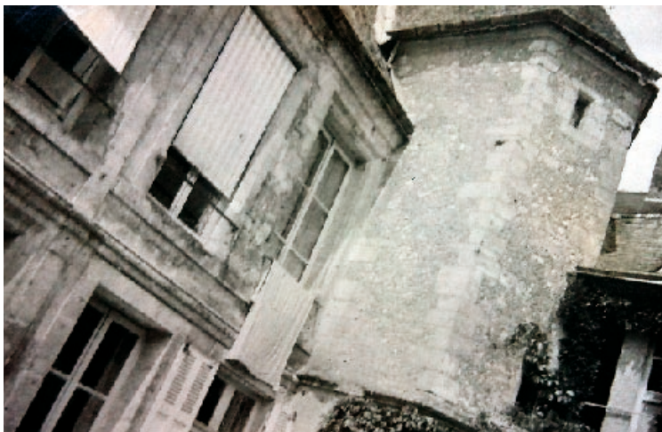
Fig. 25 : Même façade arrière avec la tourelle d'escalier (Médiathèque du Patrimoine).
