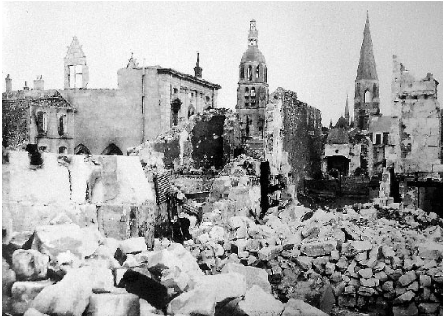
Fig. 4 : Photographie prise pendant le dégagement des ruines : à ce moment-là, les deux lucarnes Renaissance sont encore en place et dominent les deux murs, est et ouest, de l'ancienne Halle aux Blés (coll. ISV).
