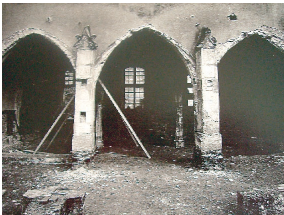
Fig. 10 : Les trois arcades de l'ancienne salle capitulaire de la Trinité (coll. part.).
