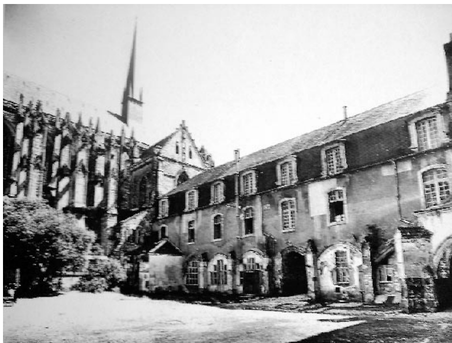
Fig. 9 : Après démolition de la galerie 'est' du cloître (coll. part.).
