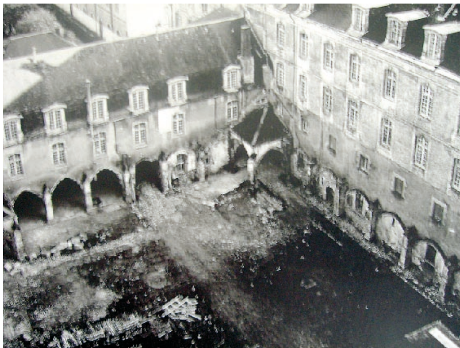
Fig. 8 : Après démolition des trois galeries du cloître (coll. part.).
