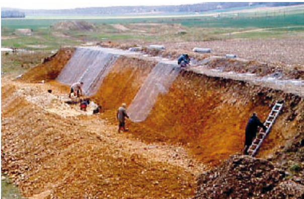
Fig. 17 : Les Grouais de Chichera y, commune de Pezou : mise en place de la protection de la coupe préhistorique (photo Jackie Despriée).
