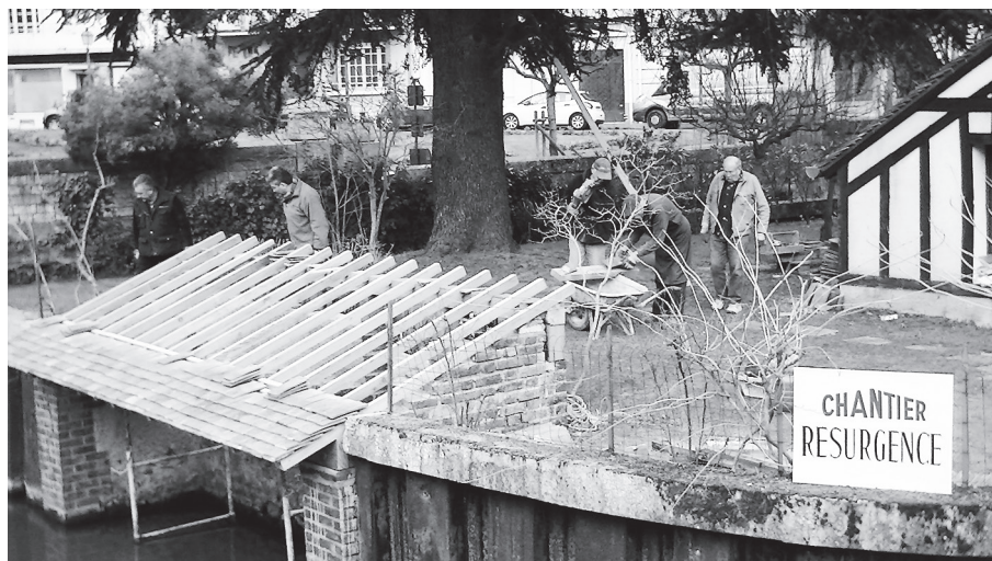
Fig. 3 : Chantier du lavoir Saint-Georges, à Vendôme.
