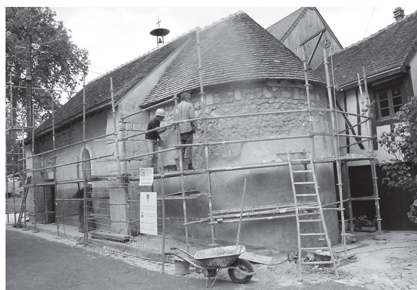
Fig. 4 : Chantier de la chapelle Saint-Pierre la Motte, à Vendôme.
