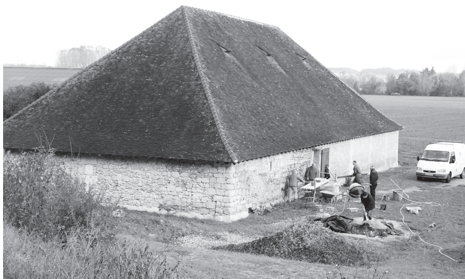
Fig. 2 : Chantier de la grange de la Couture, à Montoire-sur-le-Loir.
