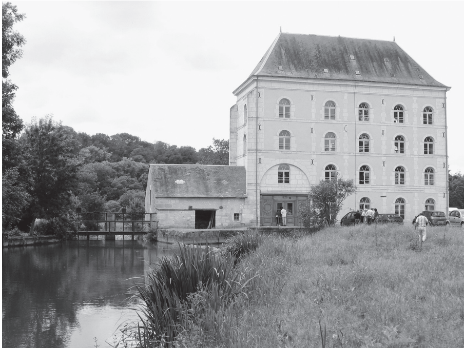
Fig. 1 : Le vieux moulin au pied du moulin moderne.
