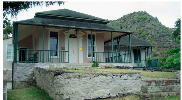
Fig. 10 : Le pavillon des Briars.
