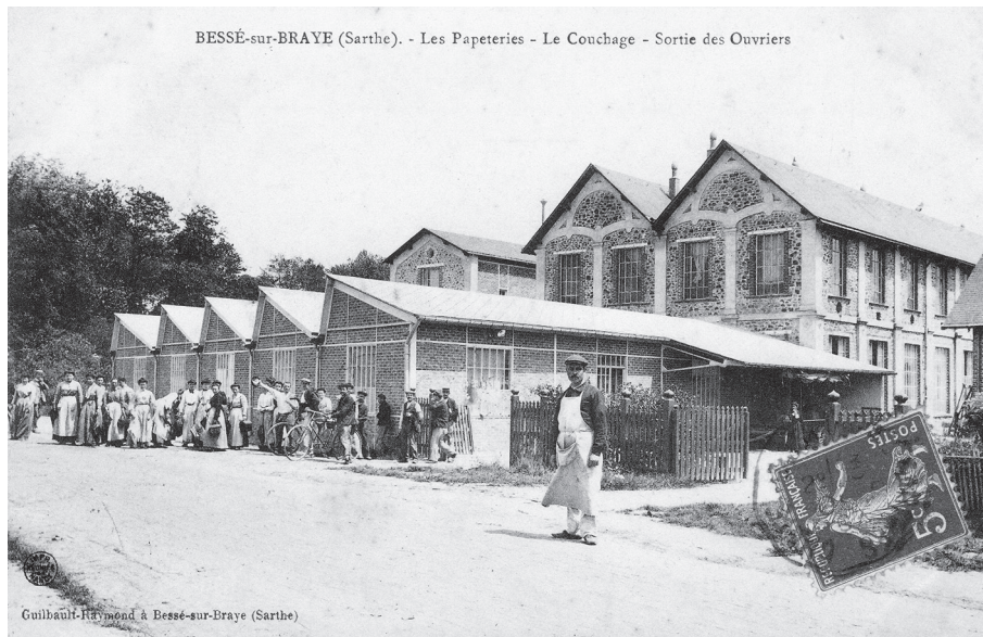
Fig. 11 : Vue générale de la papeterie de Bessé-sur-Braye, 2005 (cl. L. André).
