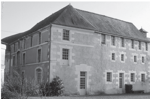
Fig. 3 : Le grand moulin de la papeterie de Paillard, 1999 (cl. L. André).
