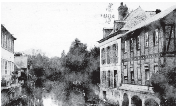
Photo 5 : Le pont Saint-Bié et la maison Bonnigal.
