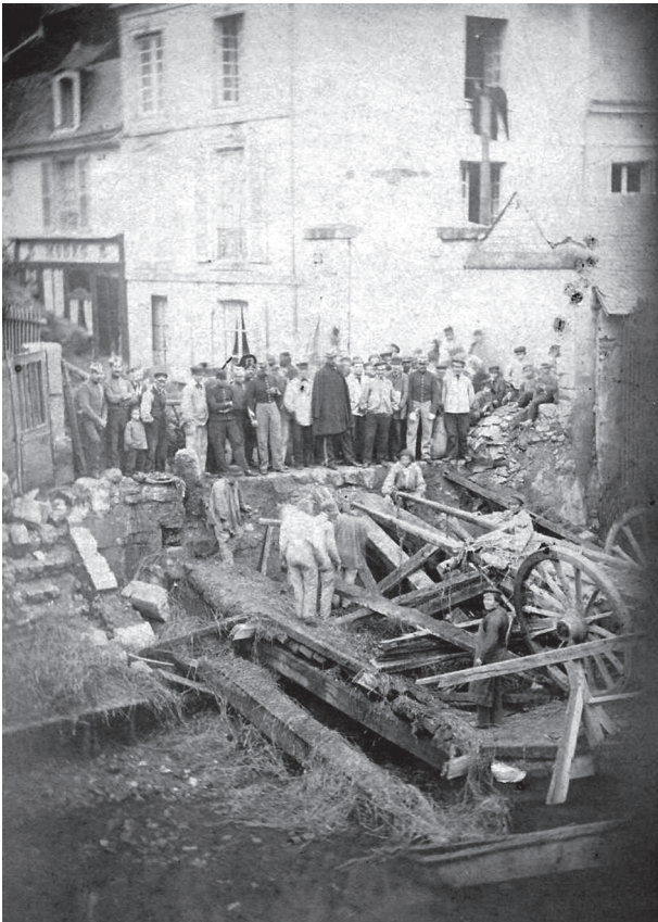
Photo 2 : Effondrement du pont Saint-Bié pris sous un angle nord-sud (fonds iconographique des Bibliothèques de la Communauté du pays de Vendôme, cote Vi 319).
