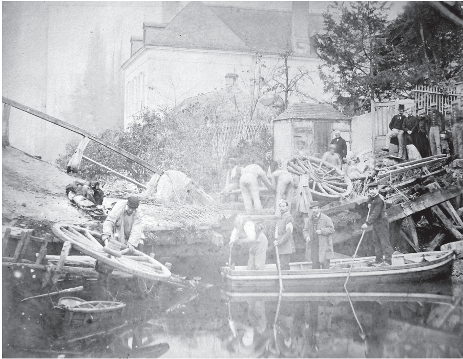
Photo 1 : Effondrement du pont Saint-Bié selon une prise de vue est-ouest (fonds iconographique de la Société archéologique).
