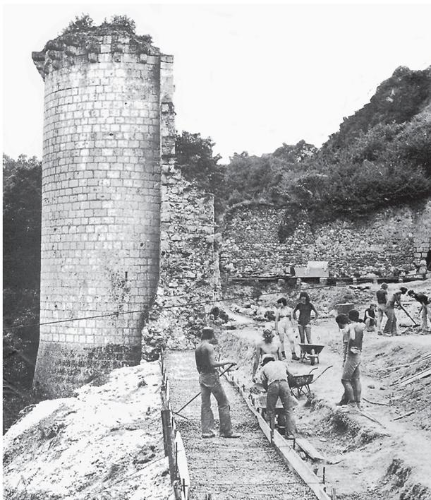
**Fig. 31** : Mise en place de la semelle de béton servant de fondation à la restitution de la courtine touchant au châtelet, nivellement du premier palier du promontoire (CVM, 1976).
