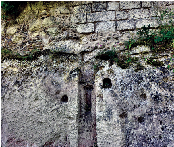
Fig. 12 : Logement d'un jambage de bois autrefois encastré dans le rocher du second palier du promontoire, probablement pour supporter le plancher de l'étage de la cuisine castrale, rocher et appareillage de l'enceinte du second palier.
