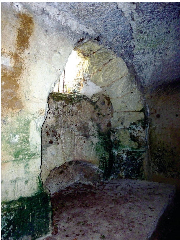
Fig. 10 : Silo (récemment comblé), surmonté de ses deux arcs de décharge, dans le corps de garde (B) situé à l'entrée des souterrains du premier palier du promontoire.
