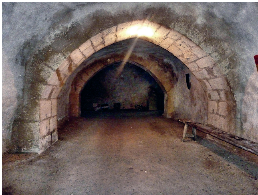
Fig. 7 : Entrée du grand cellier avec ses arcs de soutènement (D).
