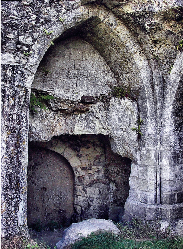
Fig. 13 : Rocher parementé de la crypte de la chapelle castrale, pour partie encastrée dans le flanc du second palier du promontoire.
