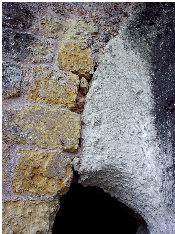
Fig. 8 : Raccord entre le rocher du second palier du promontoire et le parement de la tourelle flanquant la seconde enceinte, en arrière du châtelet.
