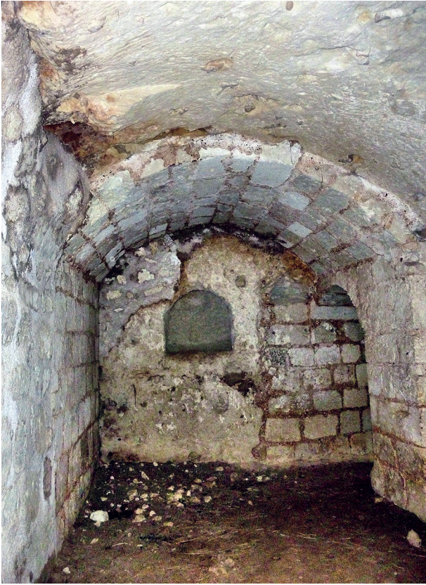
Fig. 16 : Détail du rocher apparent ou parementé, niche pour lampe à huile, à l'intérieur du sas d'accès à l'escalier souterrain du donjon (b).
