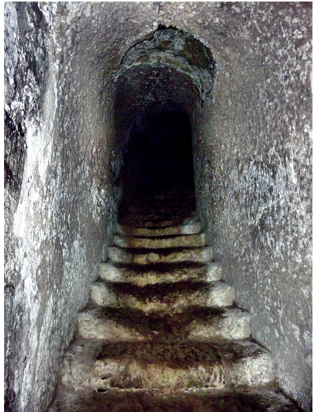
Fig. 14 : Escalier souterrain (F-G) permettant l'accès du grand logis du second palier du promontoire depuis la galerie montant vers la crypte de la chapelle castrale.
