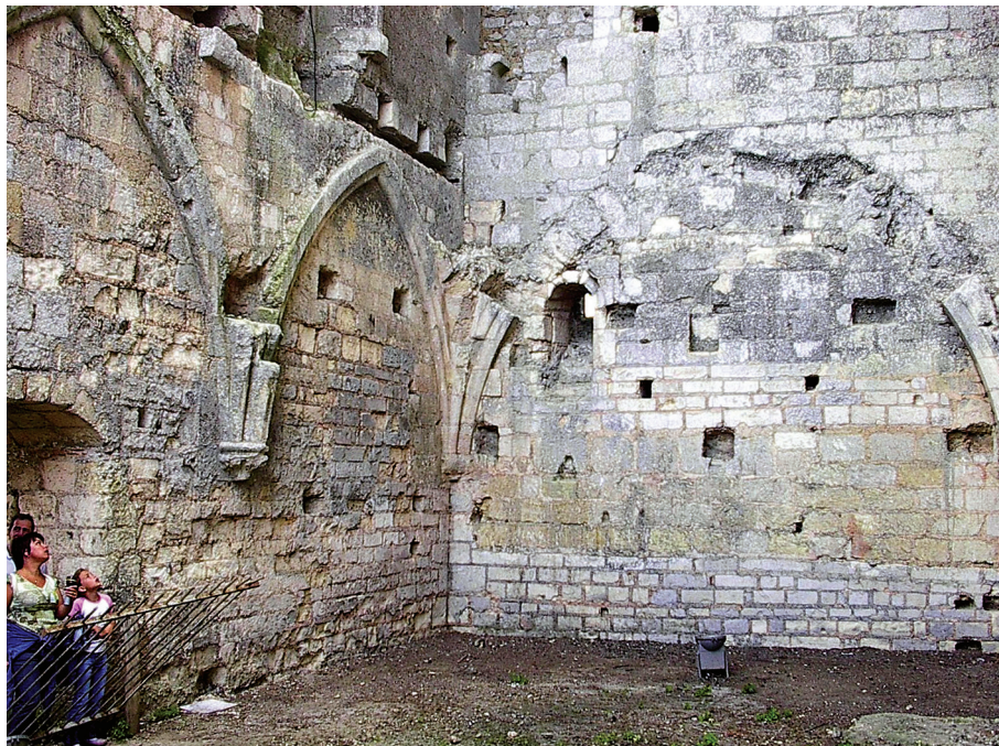
Fig. 17 – Remaniements des parements de la salle basse du donjon : appareil allongé du domicilium des premiers seigneurs (fin XI e siècle), moyen appareil du premier donjon (XII e siècle), porte et arcs formerets de la reconstruction de Jean VII (fin XIV e siècle), logements du plancher de la restructuration de Louis I er (début XV e siècle).
