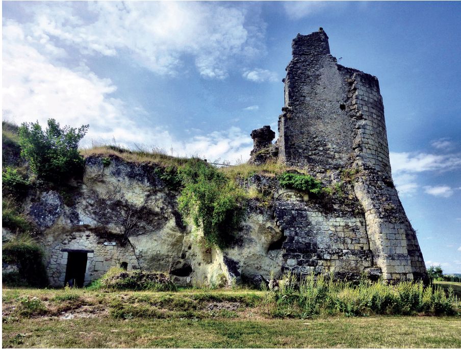
Fig. 4 : Second palier du promontoire, retaillé et parementé au pied de la tour dite du Capitaine.
