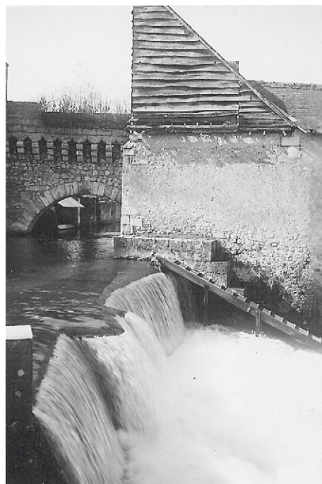
Photo 4 : Le déversoir du Dos d'Âne ou des Grands-Prés (coll. part.).
