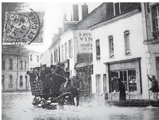
Photo 6 : Crue de 1910, rue des Quatre-Huyes (coll. part.).
