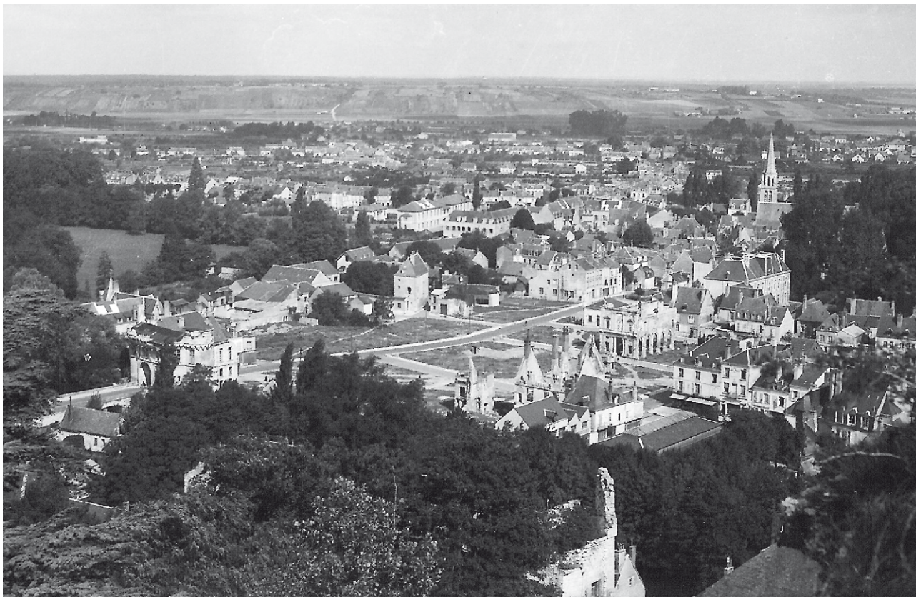
Fig. 30 : Le quartier détruit, après enlèvement des décombres [coll. ISV].
