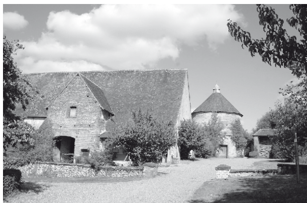
Fig. 17 : La grange et le pigeonnier de l'ancienne commanderie d'Arville, dont Jean Lecesne était le fermier (cl. M. Loisel).
