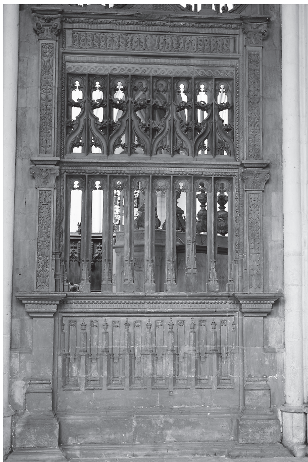
Fig. 3 : Le pan sud-est de la clôture construit sous l'abbatit de Louis de Crevant.
