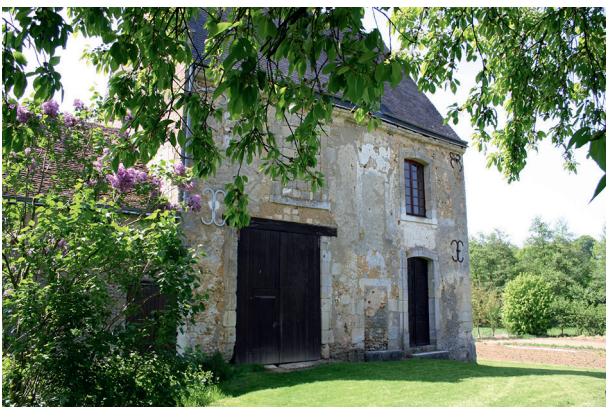
Fig. 4 : Façade principale du logis du prieur de Croixval. On voit bien, au centre, les deux portes murées après la suppression de la tourelle d'escalier.
