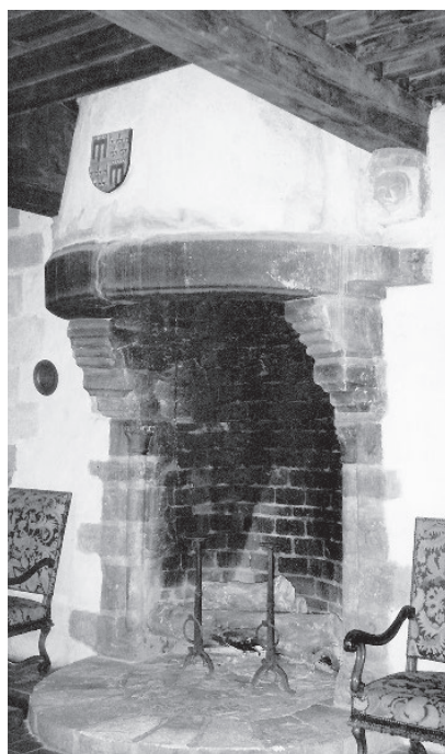
Fig. 6 : Cheminée préservée du donjon de Busséol (Auvergne).
