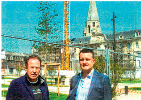
Michaël Fauvinet et Bernard Diry, samedi, devant le chantier de restauration du Bâtiment Régence recouvert d'échafaudages.
