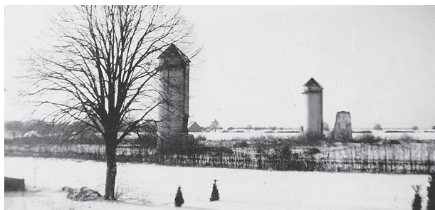
Fig. 7 : La démolition est achevée (photo Fillon 1948).
