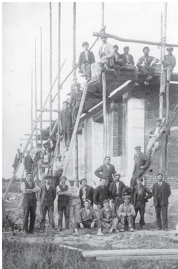
Fig. 3 : Le chantier : échafaudages (photo Guy Rentien).
