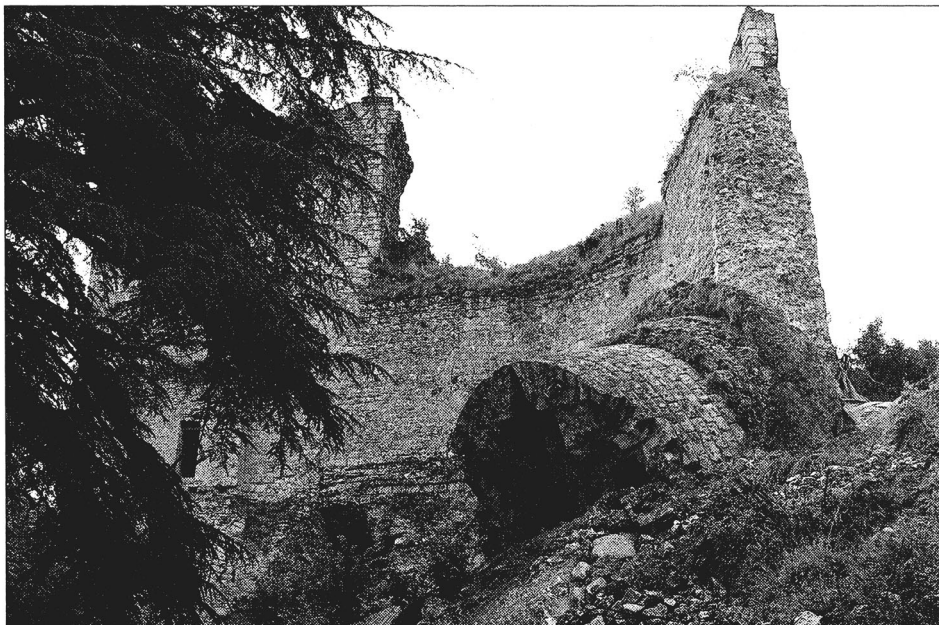
La tour du château de Vendôme s'est affaissée en mars dernier.
