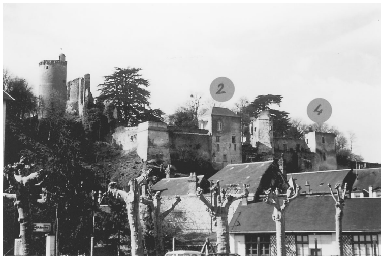
Façade nord : tour de l'Orangerie (2) et tour des Prisons (4)
