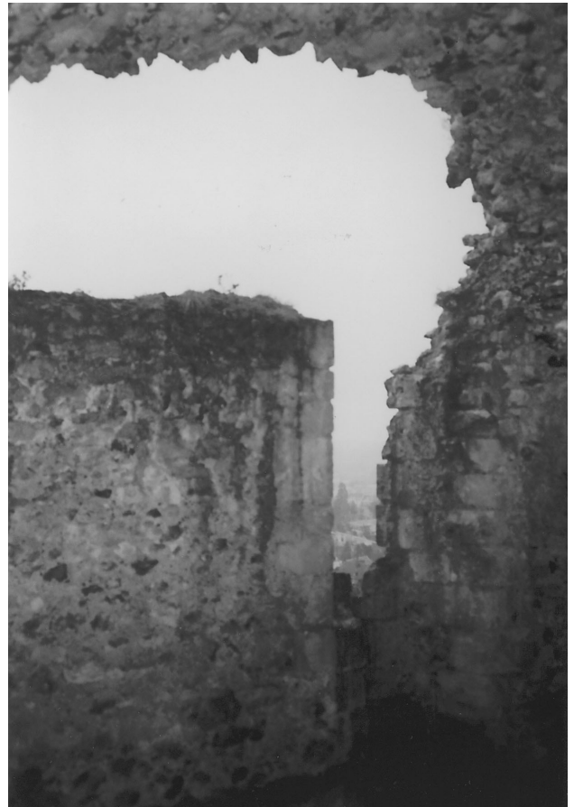
Tour de Poitiers (11) : cette même voûte vue de l'intérieur
